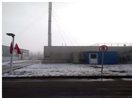
图 4-4 污水站处理站废气排放口
