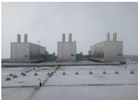
图 4-1 干化车间废气排放口
