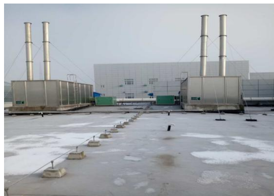
图 4-2 调配车间废气排放口
