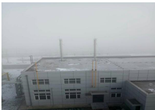
图 4-5 蒸汽锅炉废气排放口
