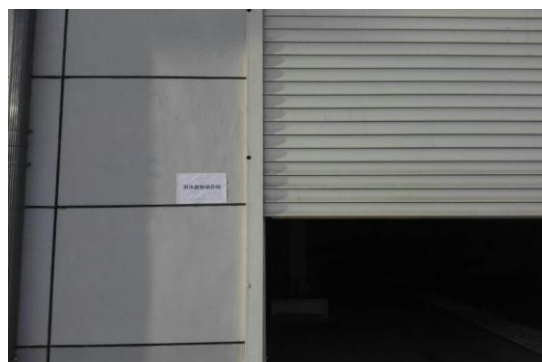
图 4-8 固体废物暂存场所
