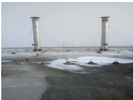
图 4-3 导热油炉废气排放口
